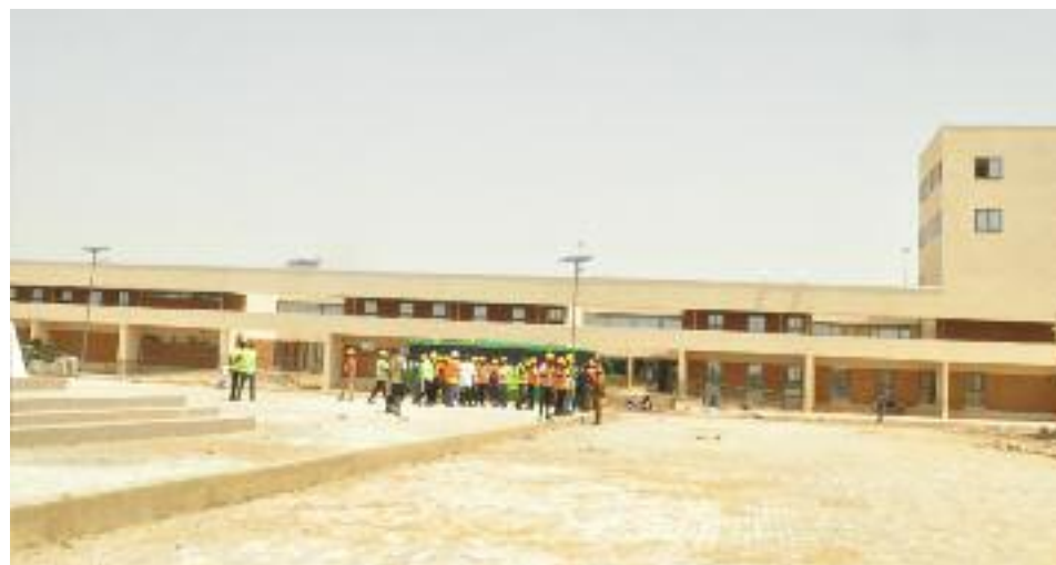
Toutes les infrastructures réalisées bénéficient d'une garantie de 10 ans
